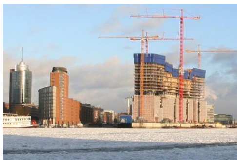
Die Baustelle der Elbphilharmonie in Hamburg. Foto: Roland Magunia
